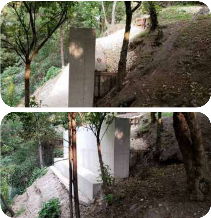
Imagen 44 - Contención talud parqueadero de estudiantes.
